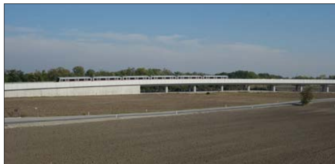
An der Station „Aspern Nord“ wechselt die Trasse von Niveau- in Hochlage. © Foto: Harald A. Jahn
