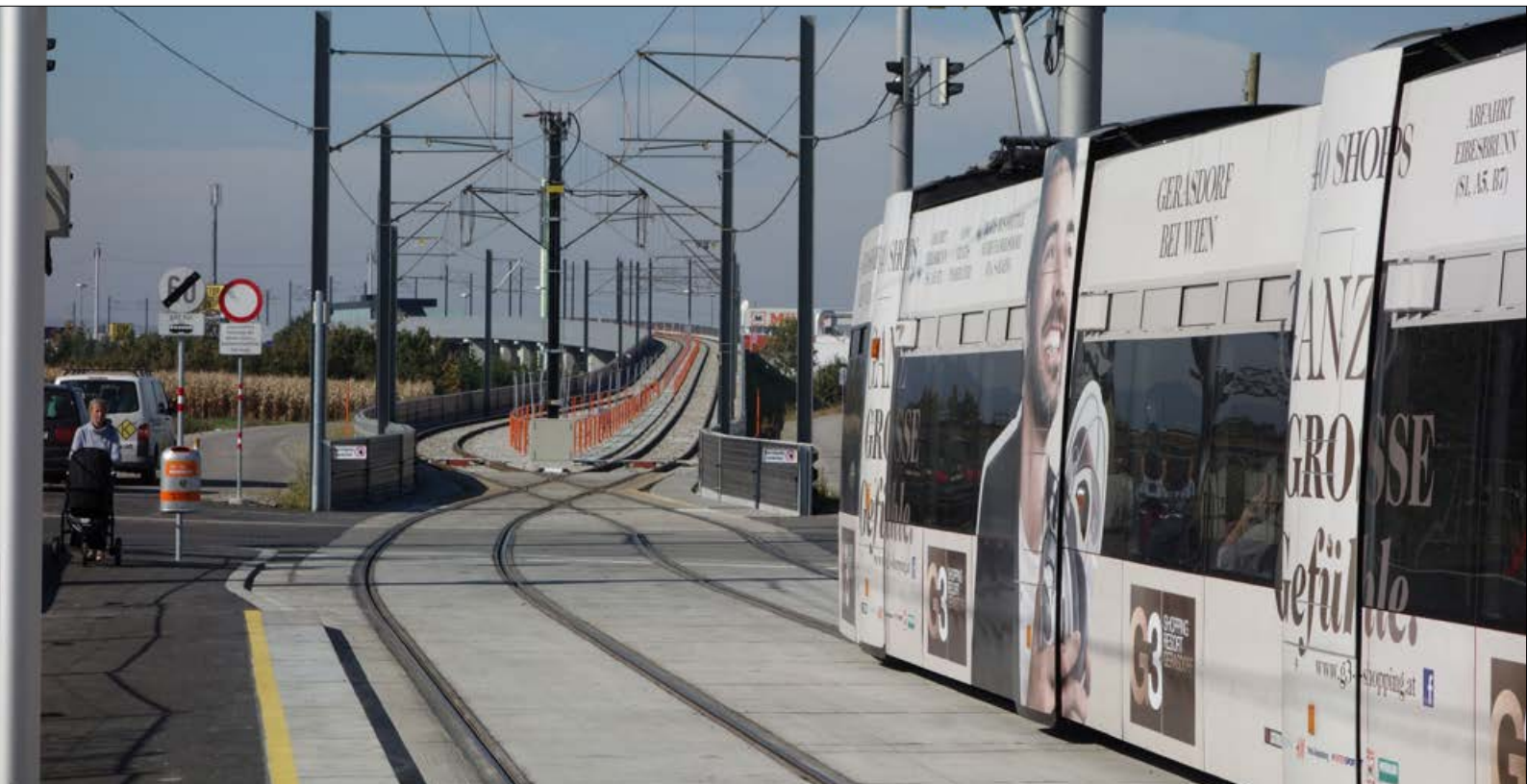
An der Einfahrt zur Hochstrecke kreuzen die Streckengleise der Straßenbahnlinie 26 einander. Der Zug trägt die Werbung für ein Einkaufszentrum an der Außenring-Schnellstraße einige Kilometer vor der Stadtgrenze Wiens. © Foto: Harald A. Jahn
