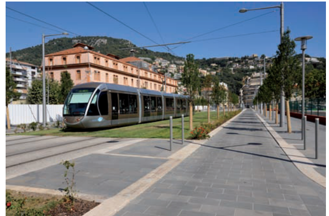
Abb. 6: Neue Straßenbahn in Nizza: sorgfältige Gestaltung des gesamten Straßenraumes. Foto: Harald A. Jahn
