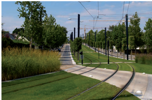
Abb. 2: Neu gestaltete Straße mit Rasengleis in Nantes.
